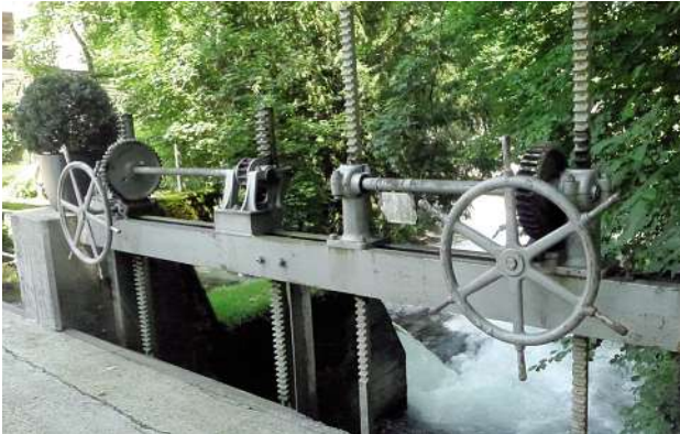
Stauwehr Hammerschmiede (Eisenhammer)
