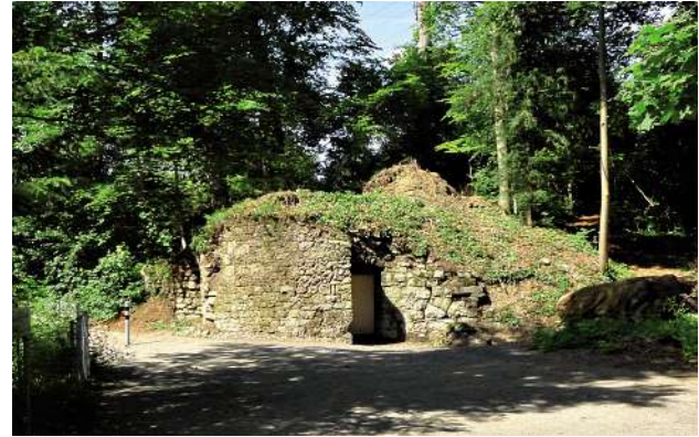
Hirzschäller vor der Wiederbelebung
